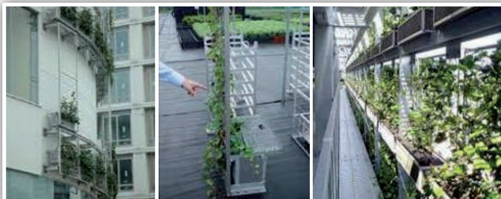
Figura 2. Sistema modular com containers da empresa GSKY Plant Systems. Fonte: GSKY Plant Systems, 2012.
