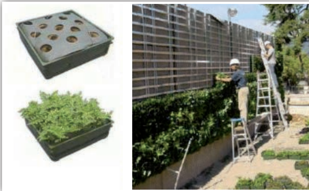
Figura 4. Sistema com módulos fixados em estrutura metálica da empresa GSKY Plant Systems. Fonte: GSKY Plant Systems, 2012.
