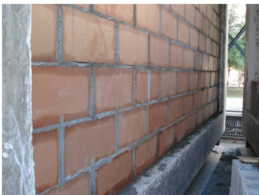
Figura 1 – Montagem da parede no pórtico do laboratório.
