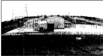
Figura 3.- Subestación multifuncional en
